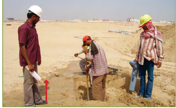
شكل 3.1.2 تحديد مكان كابل 132 كيلوفولت في الحفرة التجريبية.
